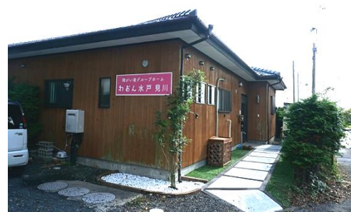
図 サブリースによって障害者グループホームとして活用する木造平家建て住宅
