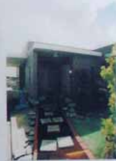
最上階の一戸建て風住宅
